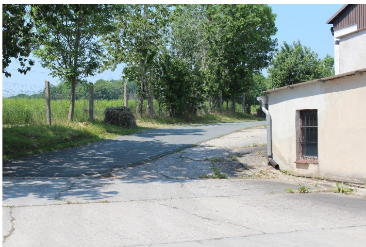
Abb. 3: südwestliche Grenze des Gewerbegebietes mit Baumreihe und angrenzender Ackerfläche (Quelle: Dienstleistungsbetrieb Würsig GmbH)
